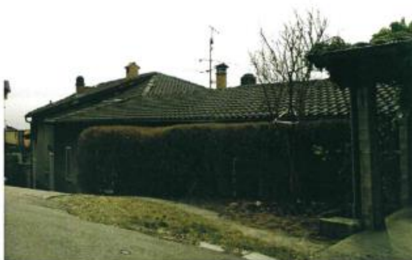
(vista da nord-est)
